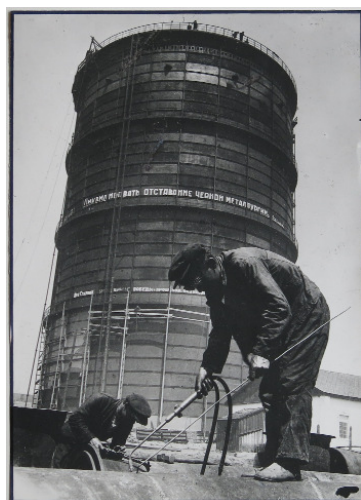
58 • KHALDEI. Construction en 1934 d'un réservoir de gaz à Stalino, dans le Donbass (bassin minier d'Ukraine). Sur le réservoir, cette exhortation de Staline : "Liquidons le retard de la métallurgie lourde".
